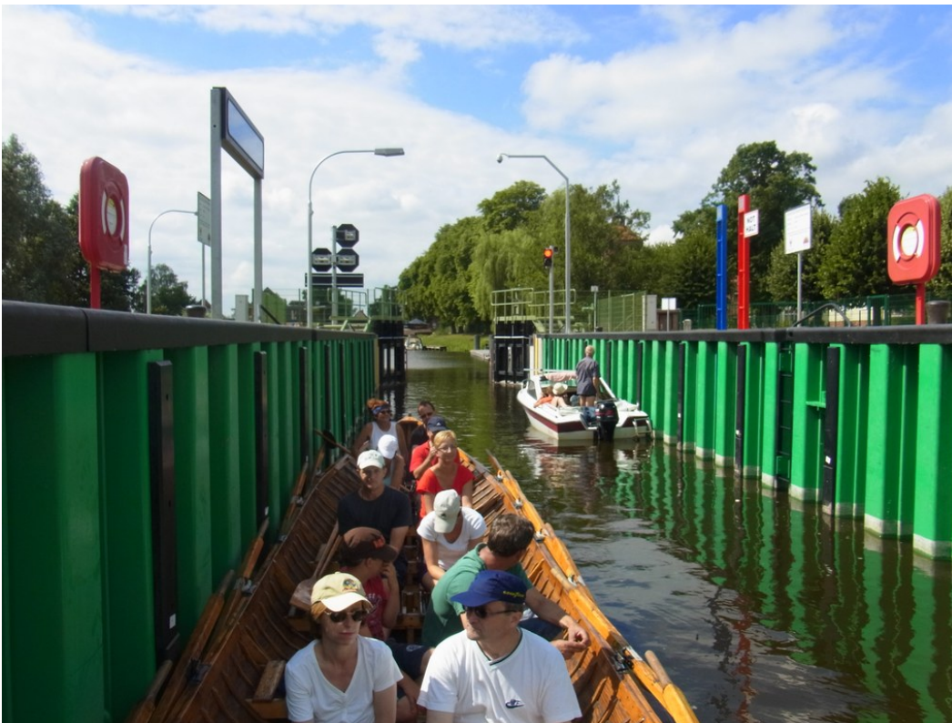
Gelobt wird von vielen Vereinen die Modernisierung der Schleuse in Beeskow (2013).
